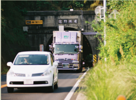
(隘路・老朽トンネル/大田市仁摩町)
