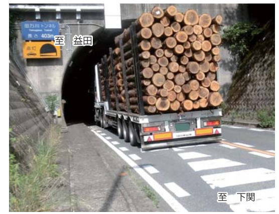
国道191号の幅員狭小トンネル
