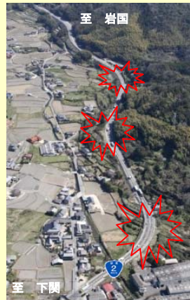
急カーブによる危険箇所(航空写真)
