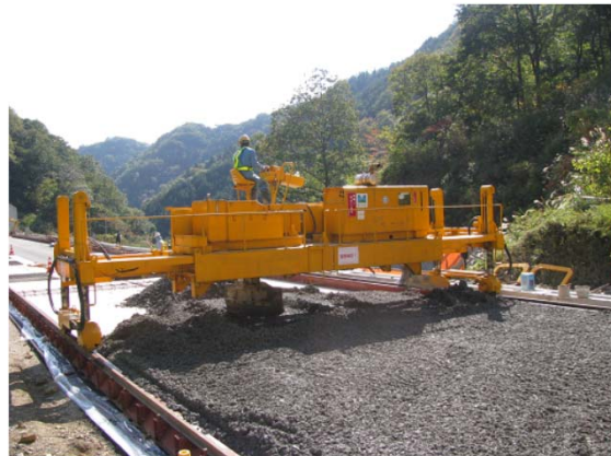
スプレッダーによるCo敷き均し
