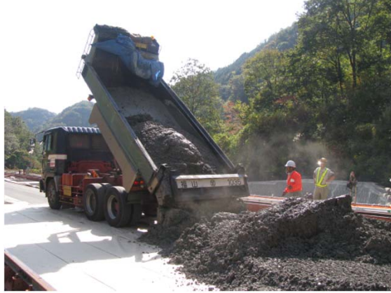
Co荷卸し(ダンプトラック運搬)
