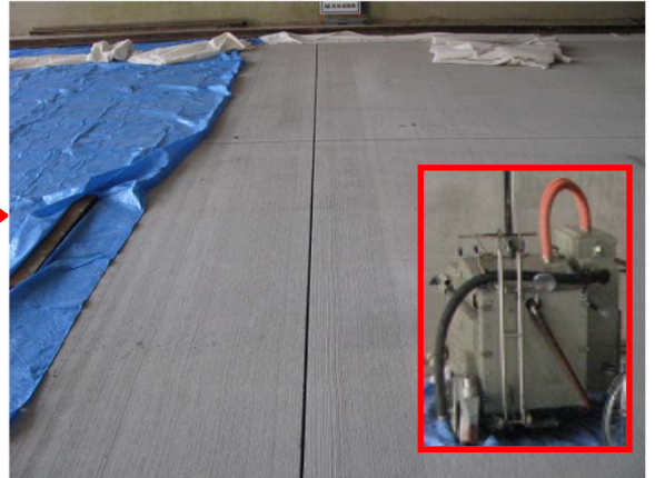
カッターによる目地切り
