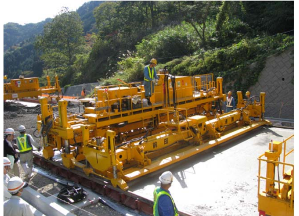
Coフィニッシャーによる締固め
