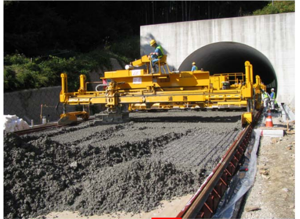
Coフィニッシャーによる締固め
