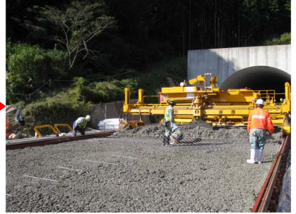
Co敷き均し(2層目)
