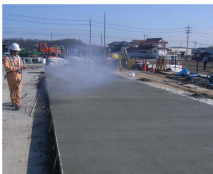
初期養生(塗膜養生)
