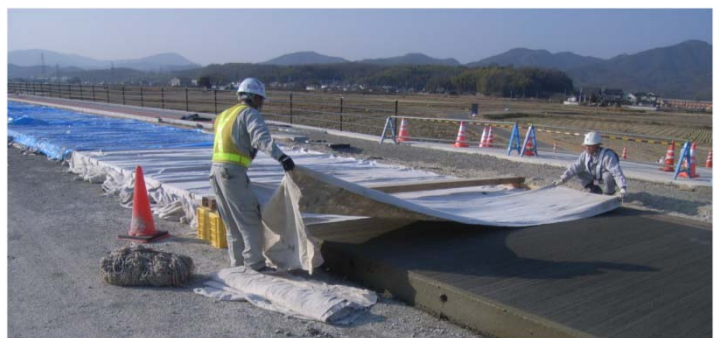
後期養生(シート養生)
