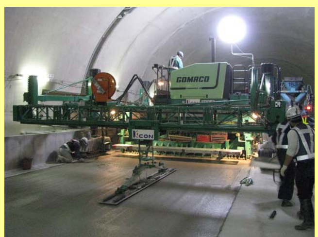
レベラ部(平たん仕上げ作業)
