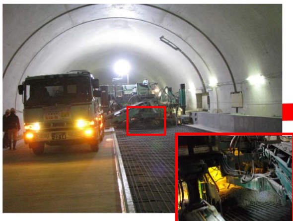
Co敷き均し(スプレッター)
