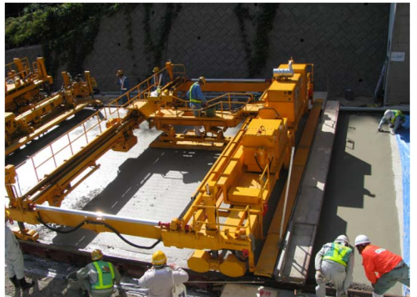
Coレベラによる平たん仕上げ
