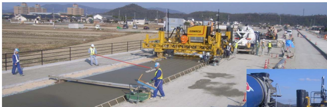
コンクリート舗装施工状況
