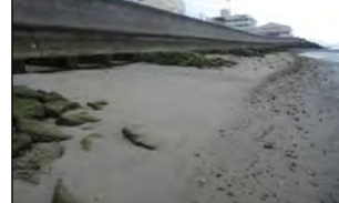
広島港海岸での高潮対策護岸整備にあわせた生物配慮型護岸の整備 (中国地方整備局)
