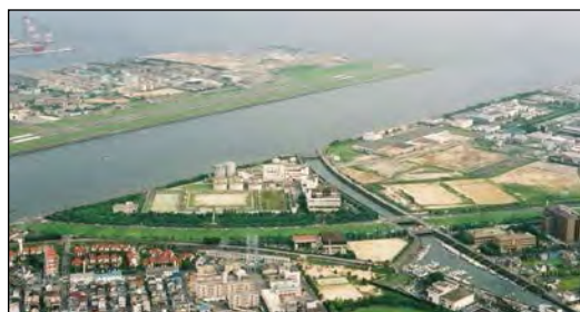
西部水資源再生センター (広島市: 増設中)
