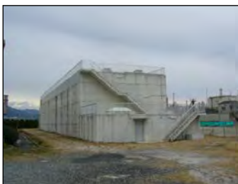
大竹処理区 雨水滞水池(完成)
