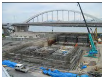
雨水滞水池(千田地区)の増設(広島市)
