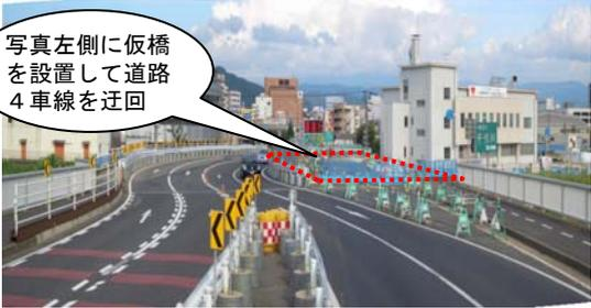
写真左側に仮橋を設置して道路4車線を迂回
