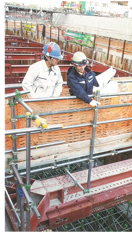
▲指示通り安全に作業しているか確認していく。「一番深いところで現在12メートルあります。品質の高いコンクリート構造物を作ろうと、職人さんと一致団結して頑張っています」。
