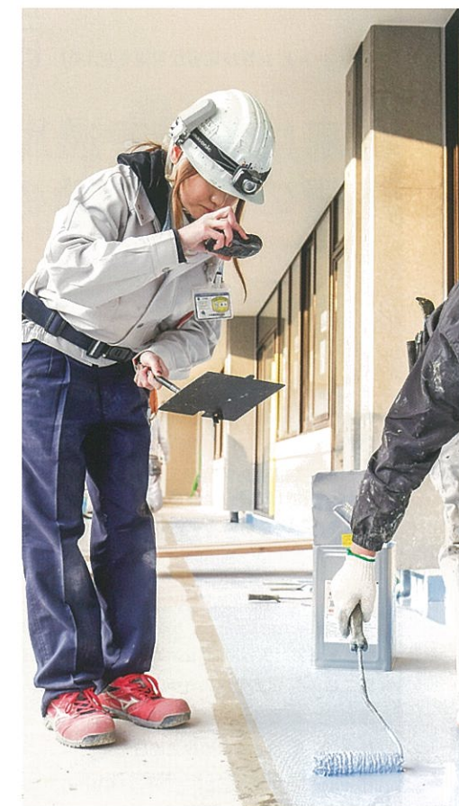
▲ウッドデッキの下に塗膜防水を施している。見えない部分になるので、証明するための写真撮影も大切な仕事。
