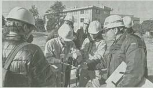
鉄筋組立体験
