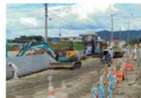
道路築造工事の土工作業風景
