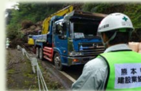
道路啓開(倒木・土砂の撤去)
