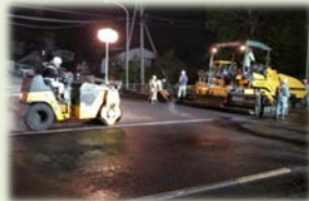
通行不能の交差点での応急工事
