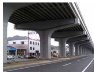
橋梁の耐震補強状況 (一般国道2号五日市高架橋)
