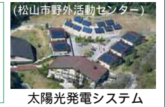
太陽光発電システム
