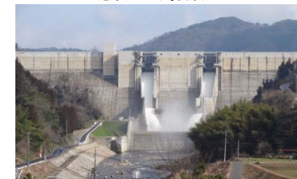
尾原ダム（島根県）
