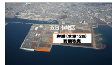
【写真】 広島港五日市地区耐震強化岸壁
