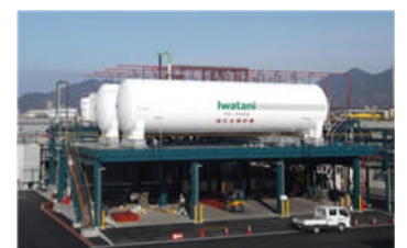
【液化水素製造プラント】
