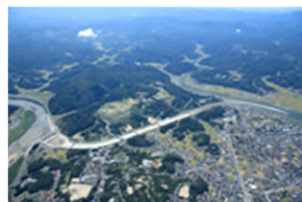
【斐伊川放水路】
