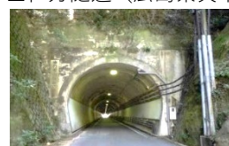
仁方隧道の状況
