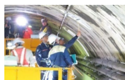
覆工コンクリートの調査状況
