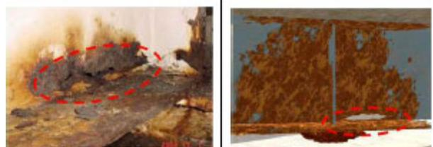
図-3 主桁の腐食写真(左) 3Dモデル(右)
