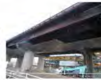
写真6 足場の撤去状況
