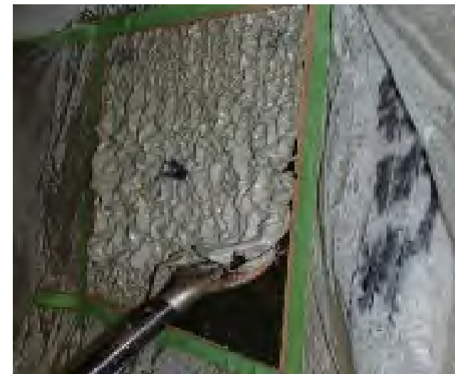
塗膜除去状況
