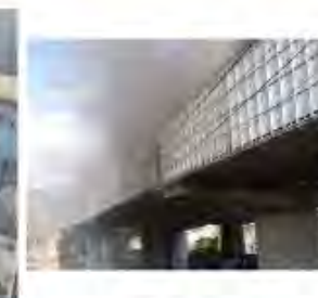
写真3 火災状況 [本線外から]
