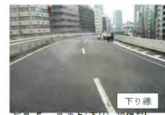
写真-5 高速上(下り) 損傷なし
