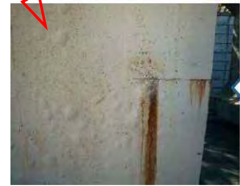
断面修復部とコンクリートの境界に沿って、ひび割れ・漏水跡。その延長上に密集した膨れが発生。
