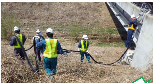
真空引きした後、 先導ワイヤに接続
