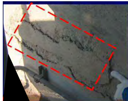
・塗装の構成 アクリルウレタン樹脂 ポリブタジエン樹脂 エポキシ樹脂 クレタプライマー（塩害） b) 塗装をはがした状態
