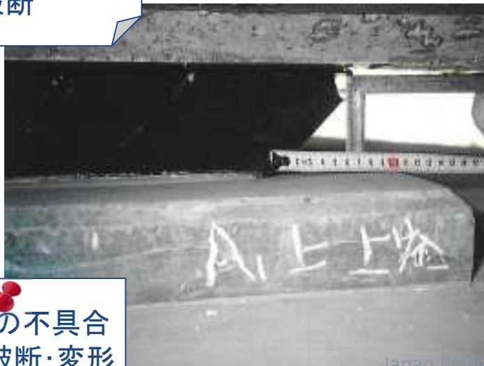
沓座コンクリートの充填 不足で空隙 下沓が破断
