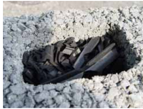
空洞部にスポンジゴムを充填
