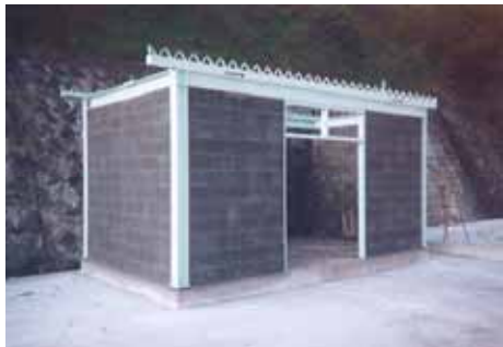
生コン工場のフロア室
