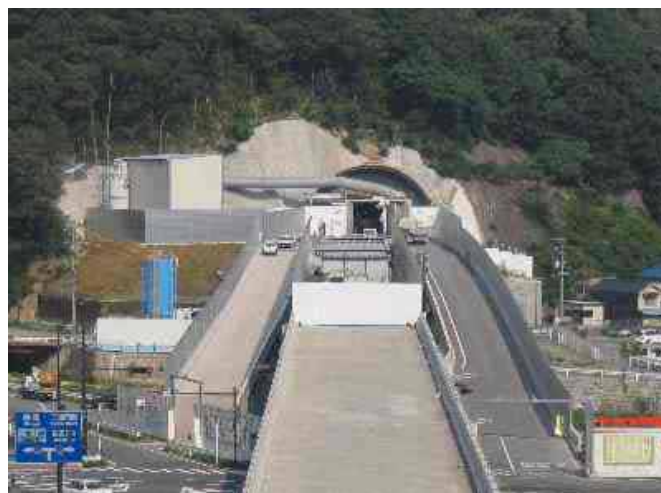
写真 1 三原第5トンネル終点側坑口
