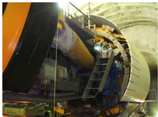
写真 4 TBM本体（側面）
