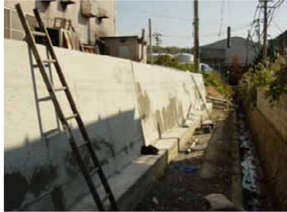
写真-4 表面ラスモルタル処理・完了
