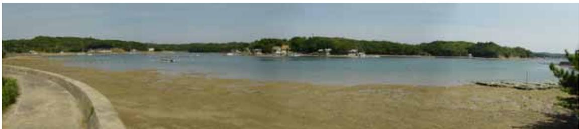
写真 4 浚渫ヘドロを用いて造成された干潟
