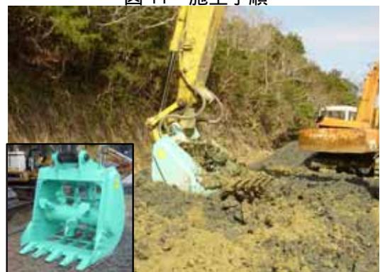
写真 2 ドライブミキシングによる混合
