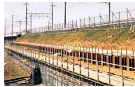
写真-4 JR 武蔵野線の鉄道盛土の補強
