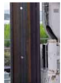
写真-5 透水性鋼矢板
