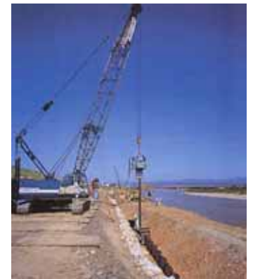
写真-1 阿武隈川での鋼矢板打設
