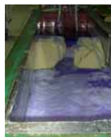
写真-2 鋼矢板なし
