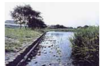
写真-6 多自然型鋼矢板護岸
