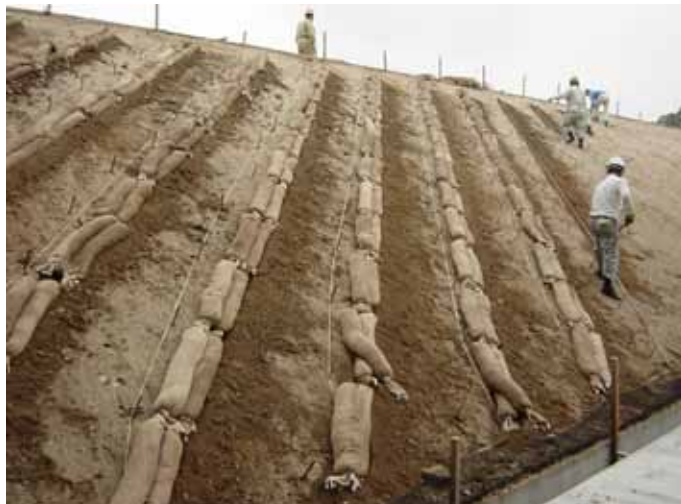
写真-5 法面へのエコ法枠施工状況
