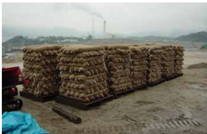
写真 - 4 チップを詰めたエコ法枠
