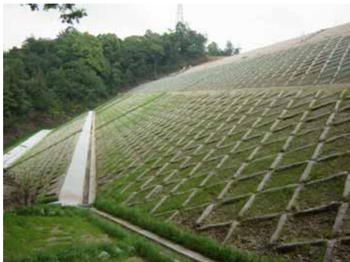
写真-6 エコ法枠施工法面1
