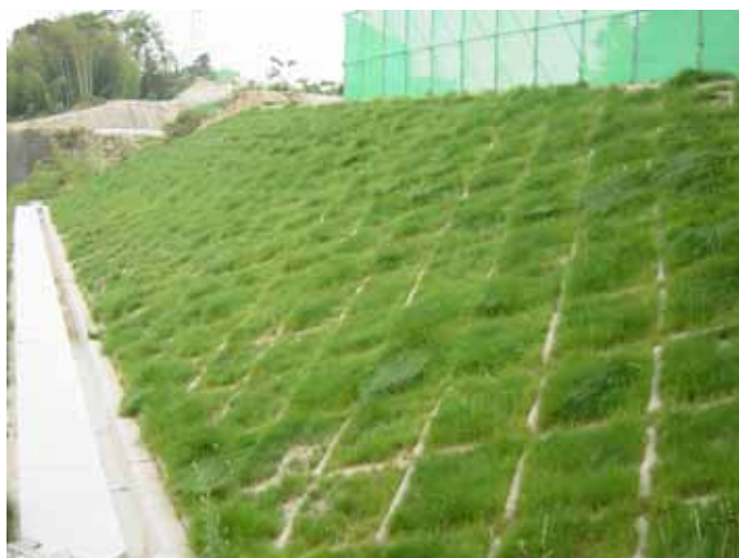
写真-7 エコ法枠施工法面2
