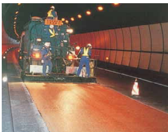
写真 - 1 施工状況
