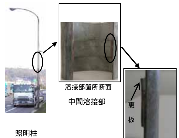
写真1. 照明柱中間溶接部
