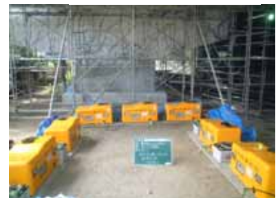
写真-8 加圧注工
