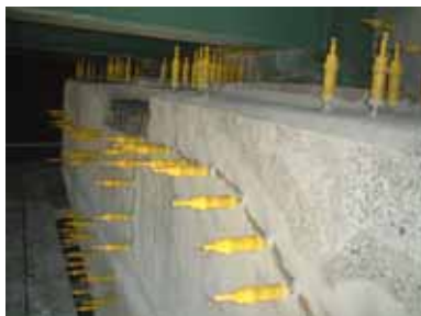
写真-6 表面漏出防止工
