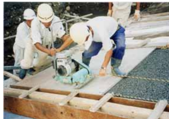
写真-4 締固め状況
