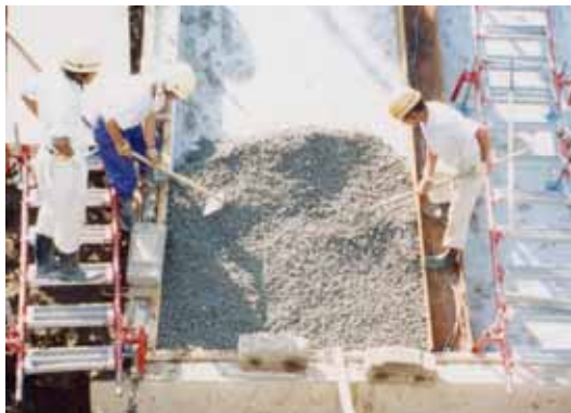
写真-3 敷均し状況
