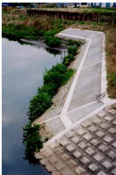
写真-7 施工後1年の状況
