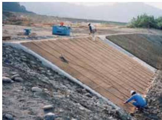
写真-6 保護ネット設置状況
