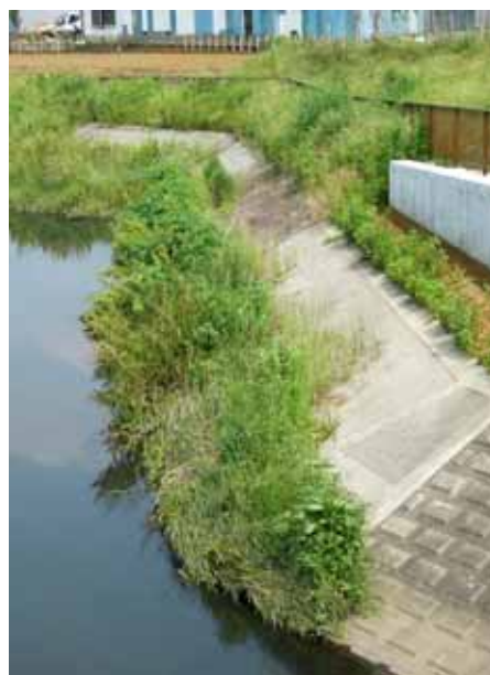
写真-8 施工後4年の状況
