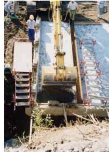
写真-2 打込み状況
