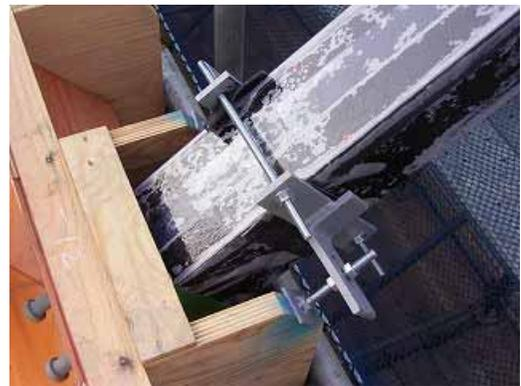
写真 3 固定金具と型枠写真
