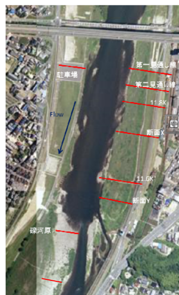
写真-2 対象区間と横断測量を行った断面（平成21年）
