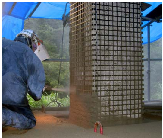
③Sto 乾式吹付けモルタルの吹付
