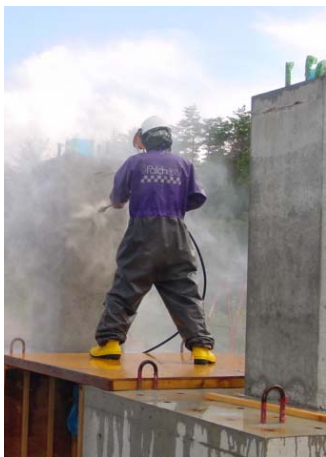
①ウォータージェットによる 下地処理
