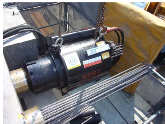
写真-8 外ケーブルの緊張
