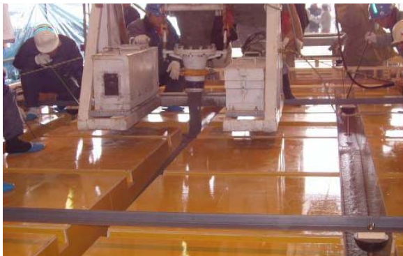
写真-5 主桁の打設
