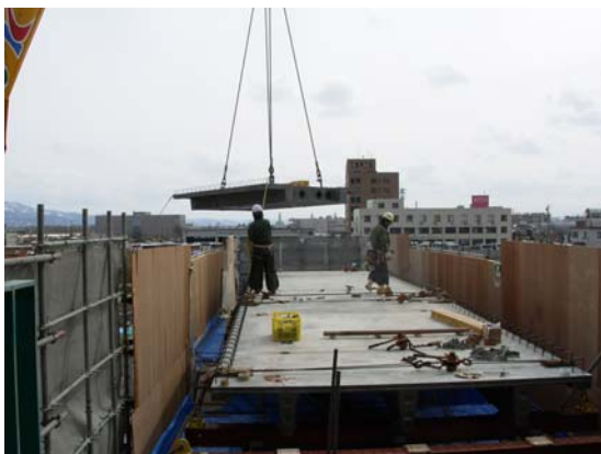
写真-6 主桁の架設
