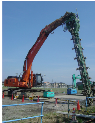
写真-2 トレンチャー式攪拌混合機
