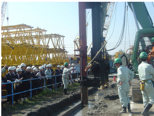
写真-5 施工実験状況
