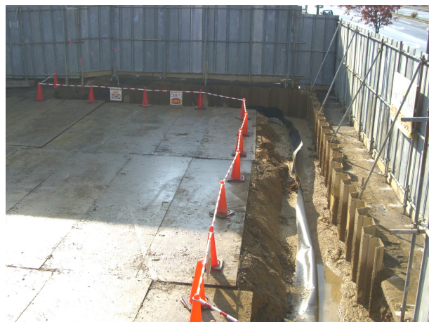
写真-6 施工完了状況
