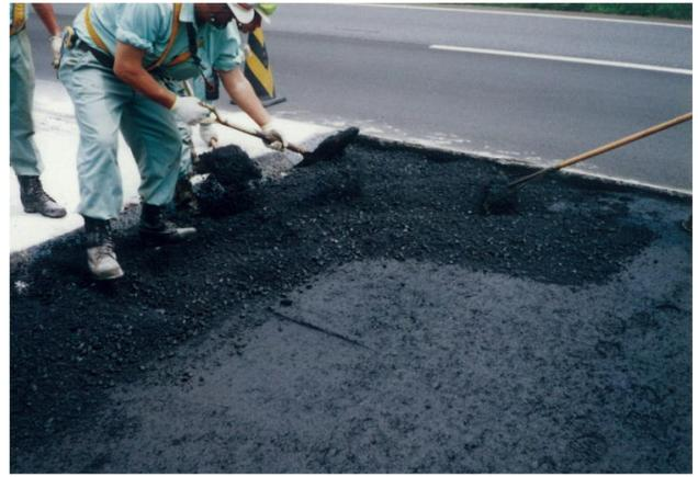
写真-4 人力施工による混合物の敷均し
