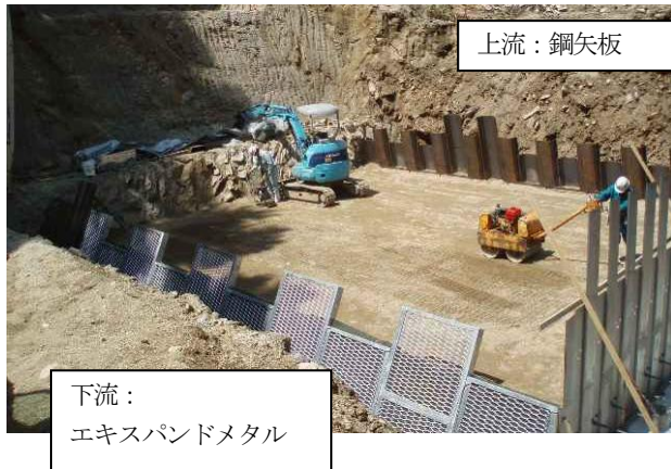
図-6 現場発生土転圧状況
