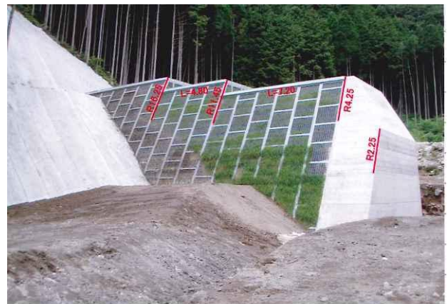
図-12 3工区完成 (H20年度施工：右岸)
