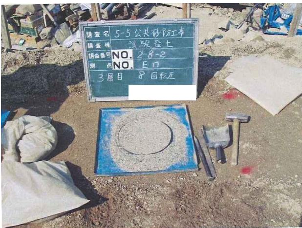
No.2-8-2 現場密度試験(8回転圧)
