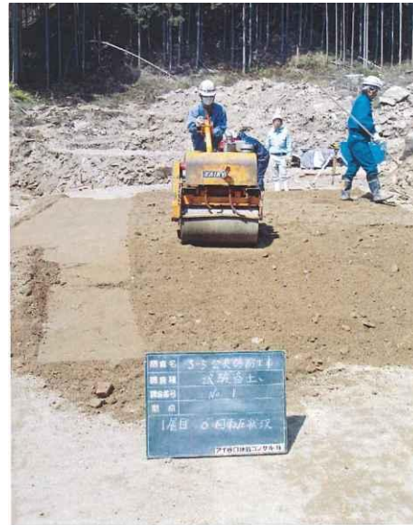
No.1 6回転圧状況
