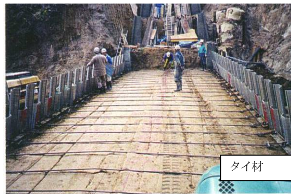
図-7 タイ材設置状況 (参考：他工区)
