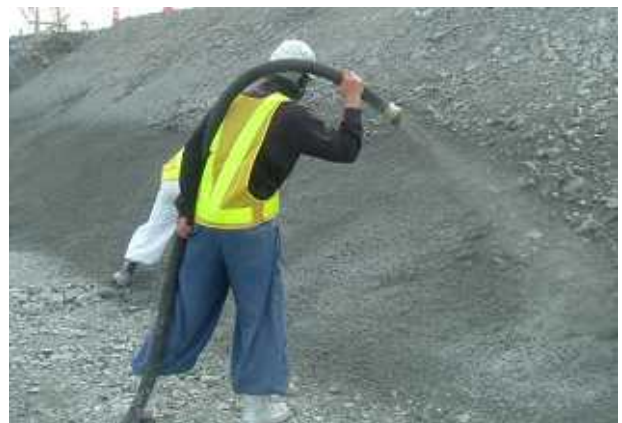
写真-1 吹付け施工状況
