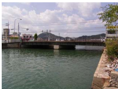
写真-4.1 施工前現況
