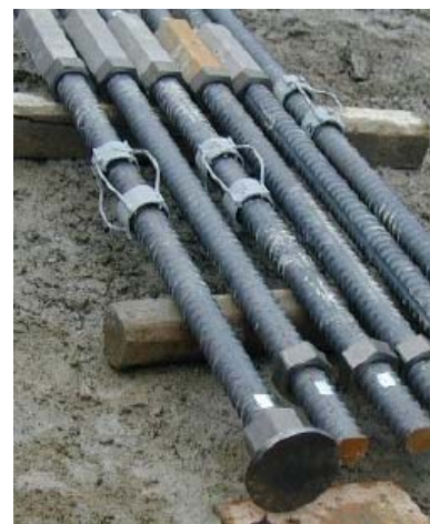
写真-2.2 芯鉄筋および継手
