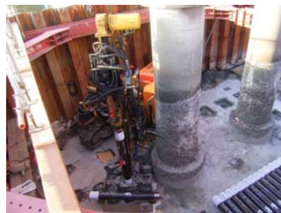
写真-4.12 マイクロパイル施工状況
