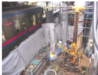
写真-4.15 マイクロパイル施工状況
