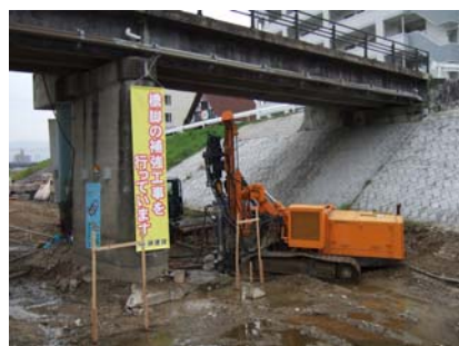
写真-4.5 マイクロパイル施工状況
