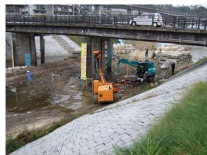
写真-4.4 築堤締切状況
