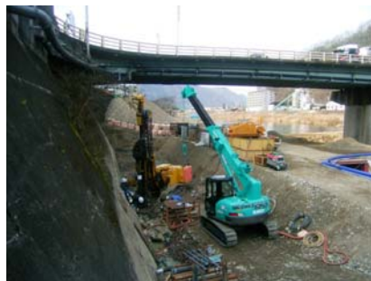
写真-4.8 マイクロパイル施工状況
