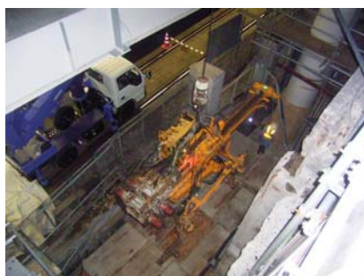
写真-4.14 ボーリングマシン吊込状況
