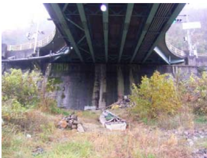
写真-4.7 施工前現況
