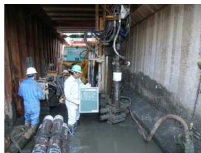
写真-4.3 マイクロパイル施工状況
