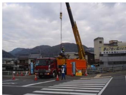
写真-4.2 ボーリングマシン吊込状況
