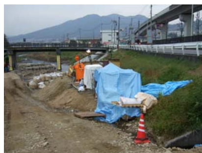
写真-4.6 プラント設置状況
