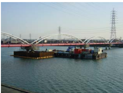
写真-4.10 施工ヤード全景
