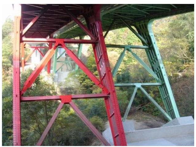
図-10 ダンパーブレースの設置状況（平林大橋）
