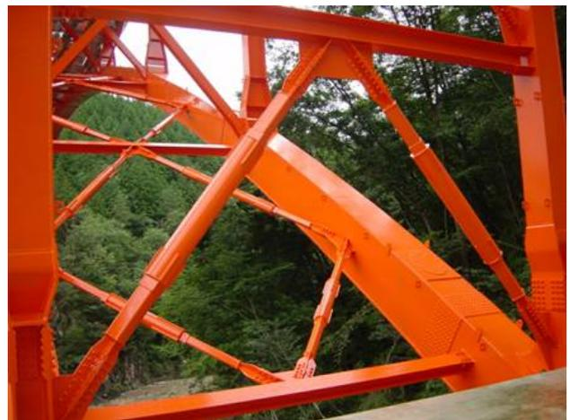
図-5 ダンパーブレースの設置状況（王渡橋）
