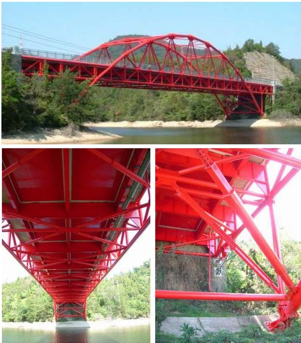
図-13 ダンパーブレースの設置状況 (伊達橋)
