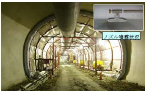
写真-3 噴霧養生台車設置状況
