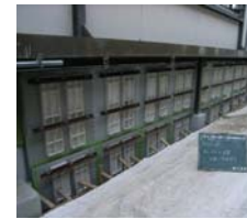
6. ボード支保工設置
