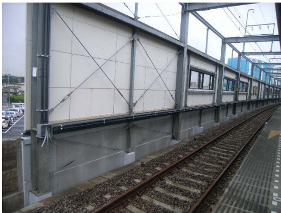
写真-5 鉄道駅舎部 軌道側全景
