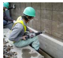
3. 連結鋼材孔あけ
