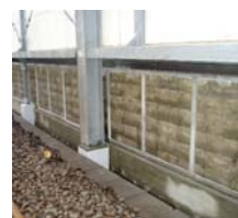
4. 裏当てボード取付け
