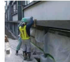
7. 充填グラウト打設
