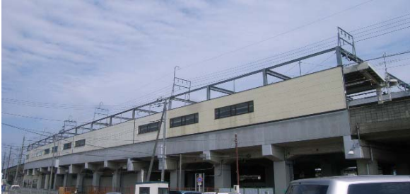
写真-4 鉄道駅舎部 外側全景
