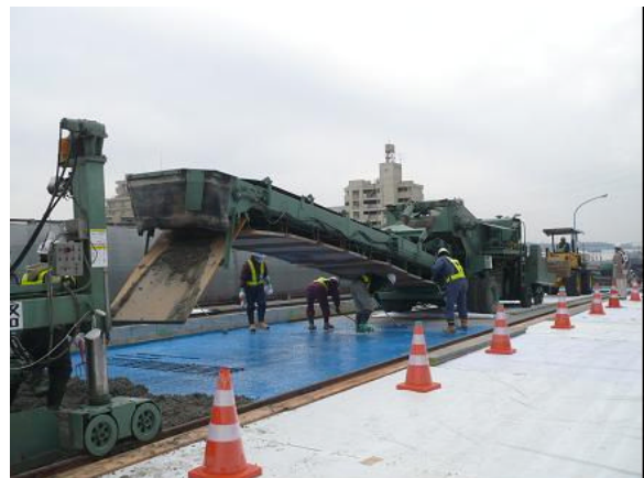
写真-4 縦取り機による SFRC 供給と接着剤塗布
