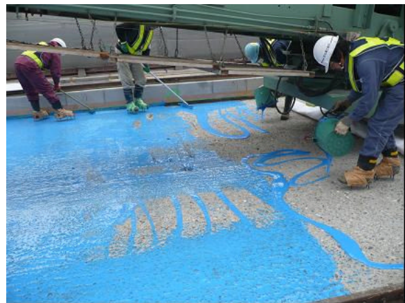
写真-3 接着剤塗布工
