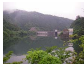
写真-2 ダムサイトを望む
