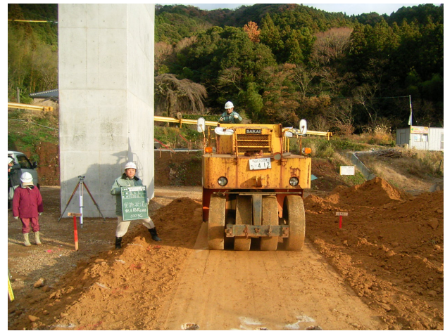
図-5 試験盛土転圧
