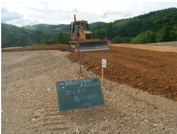
図-6 盛土敷き均し状況
