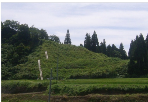
写真-6 施工後1年10ヶ月の生育状況
