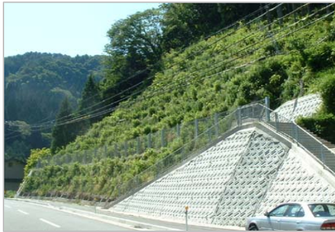
写真-9 施工後1年2ヶ月
