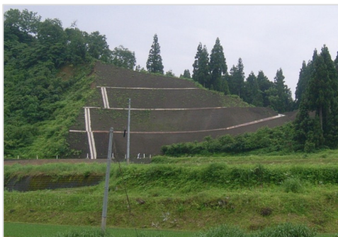
写真-5 施工後8ヶ月の生育状況
