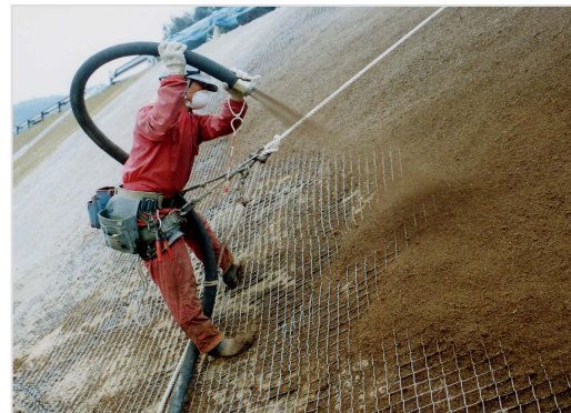
写真-1 植生基材の吹付状況
