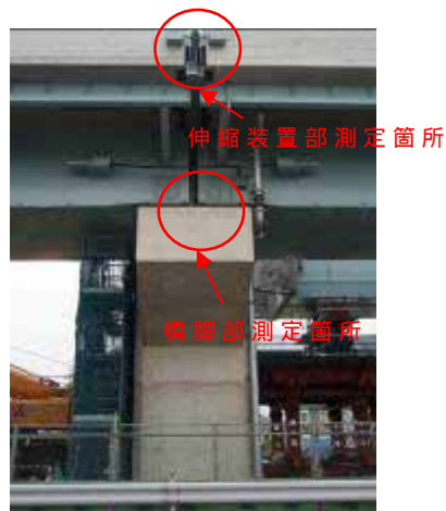
写真-4 振動測定箇所（橋脚部）
