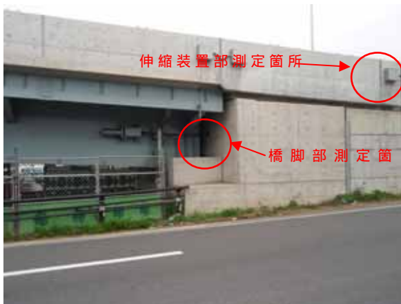
写真-3 振動測定箇所（橋台部）
