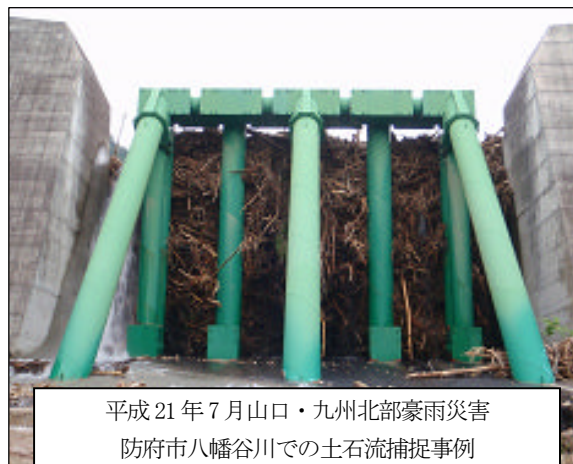
図-13 透過性えん堤 (スリットダム)
