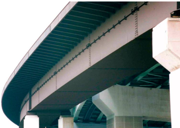
図-5 耐候性鋼による都市内高架橋
