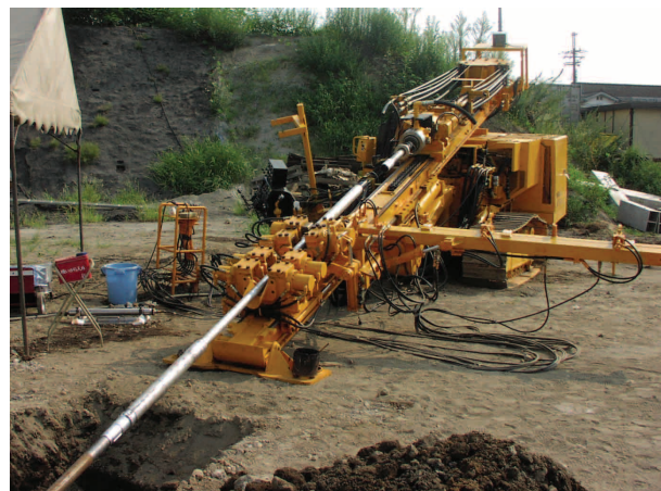
図-13 曲がり削孔機
