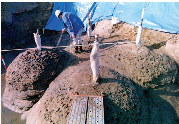
図-3 改良体の試掘状況
