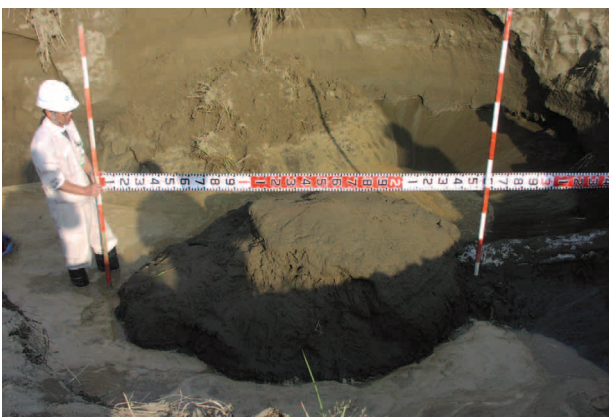
図-12 改良体開削確認状況
