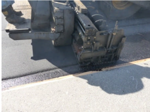
写真-1 施工状況 (端部厚さ 5mm)
