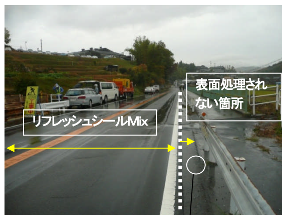
写真-5 施工後22年経過の路面
