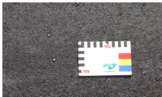
写真-4 路面の状態（施工直後）
