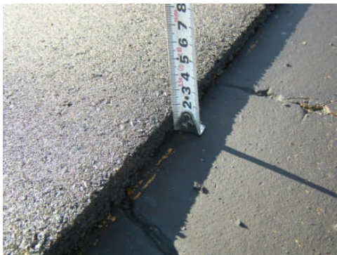
写真-2 センター部施工厚さ 15mm
