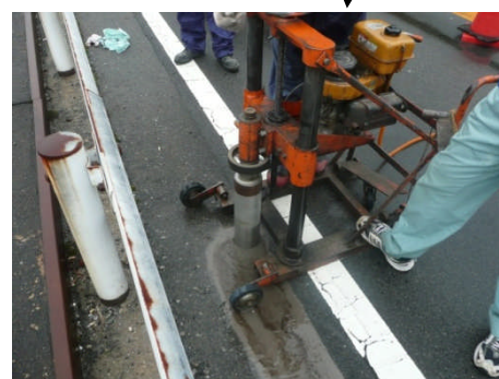
写真-6 暴露された表層部のコア採取状況
