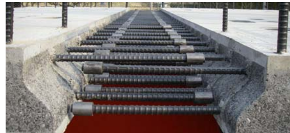
写真-3 接合部の状況（上筋：D16、下筋：D19）
