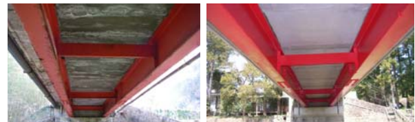
写真-4 施工前（左側）および完成（右側）
